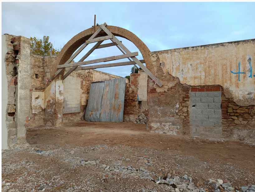
Apuntalamiento de arco de ladrillo para restaurar
