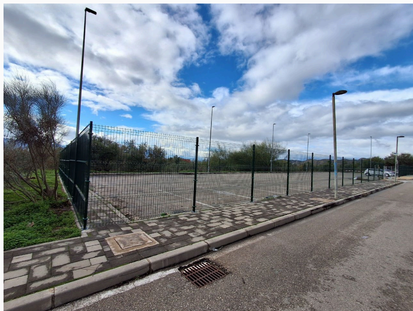
Vallado del Aparcamiento Exterior
